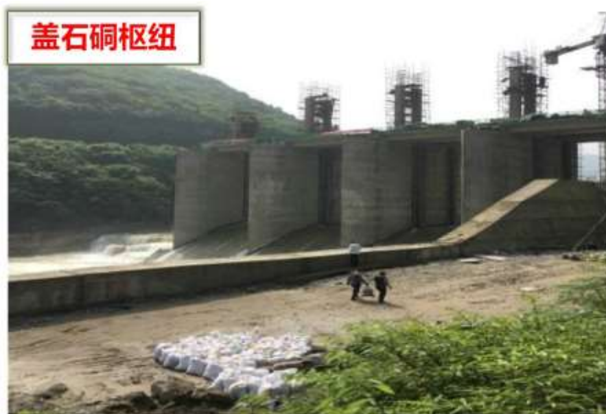
图 1.4-3 綦江干流已建梯级枢纽现状图
