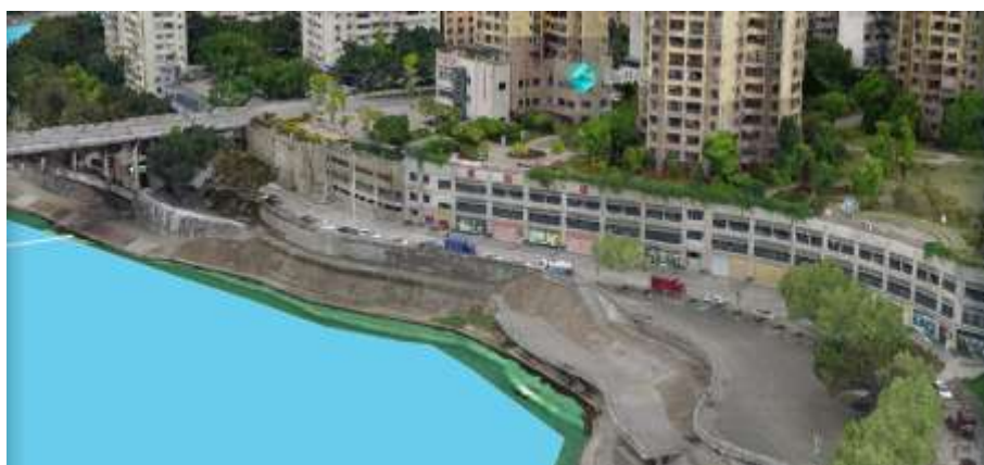
碧水南湾-沱湾大桥
