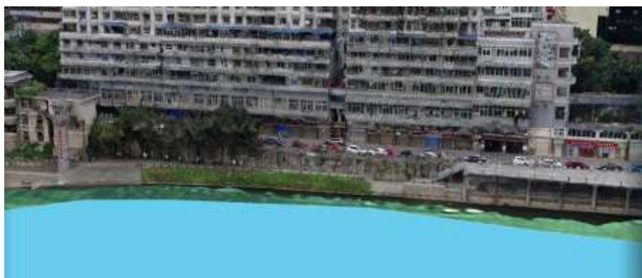
防洪亭-老电影院
