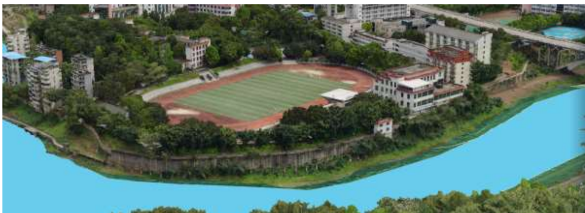
图 6.2-28 綦江左岸沙溪河口-城北大桥段地理景观图
