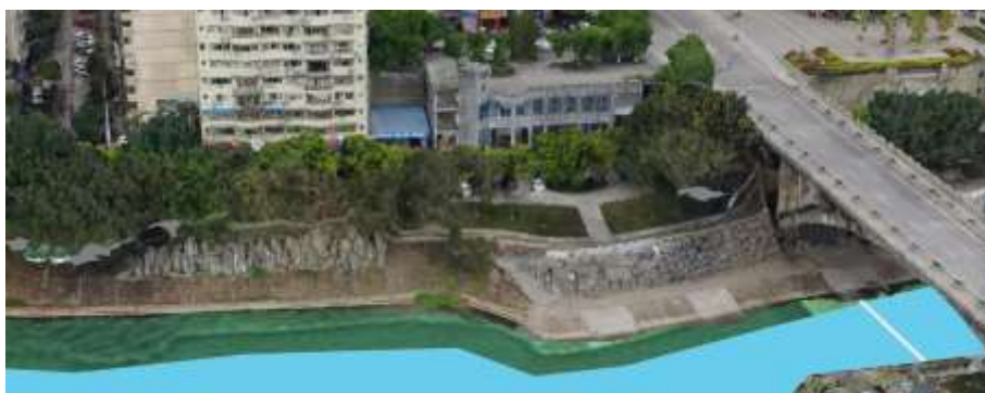
沱湾大桥-华诺世口腔
