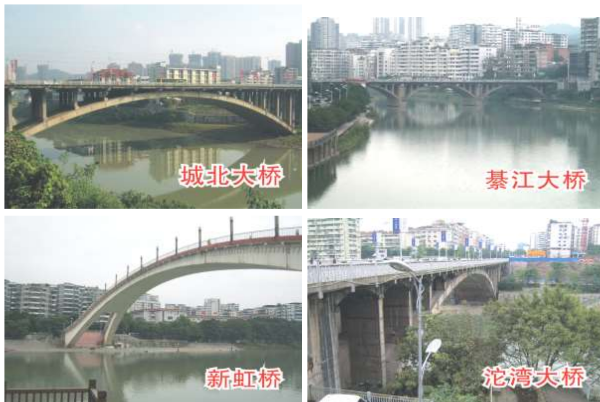
图 1.4-4 綦江干流主城区段已建跨河桥梁
