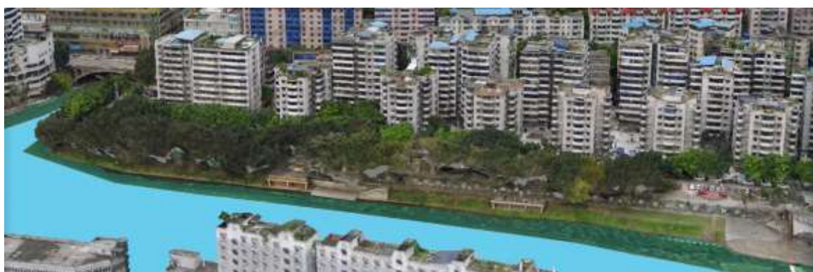
南门办公楼-通惠河口
