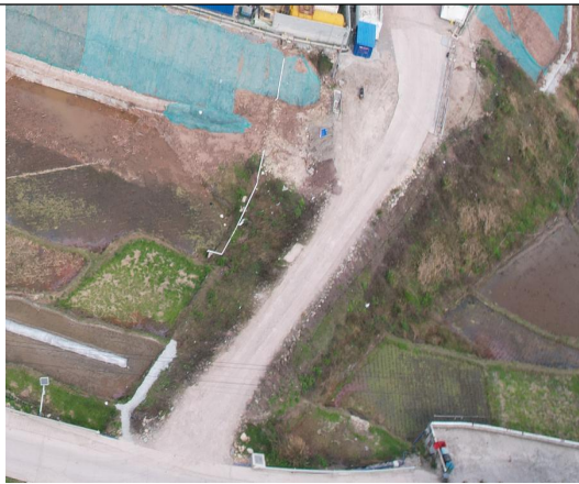
进场道路现状
