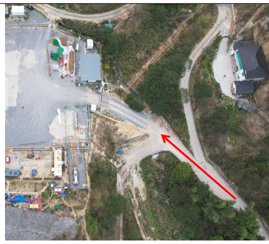
进场道路现状
