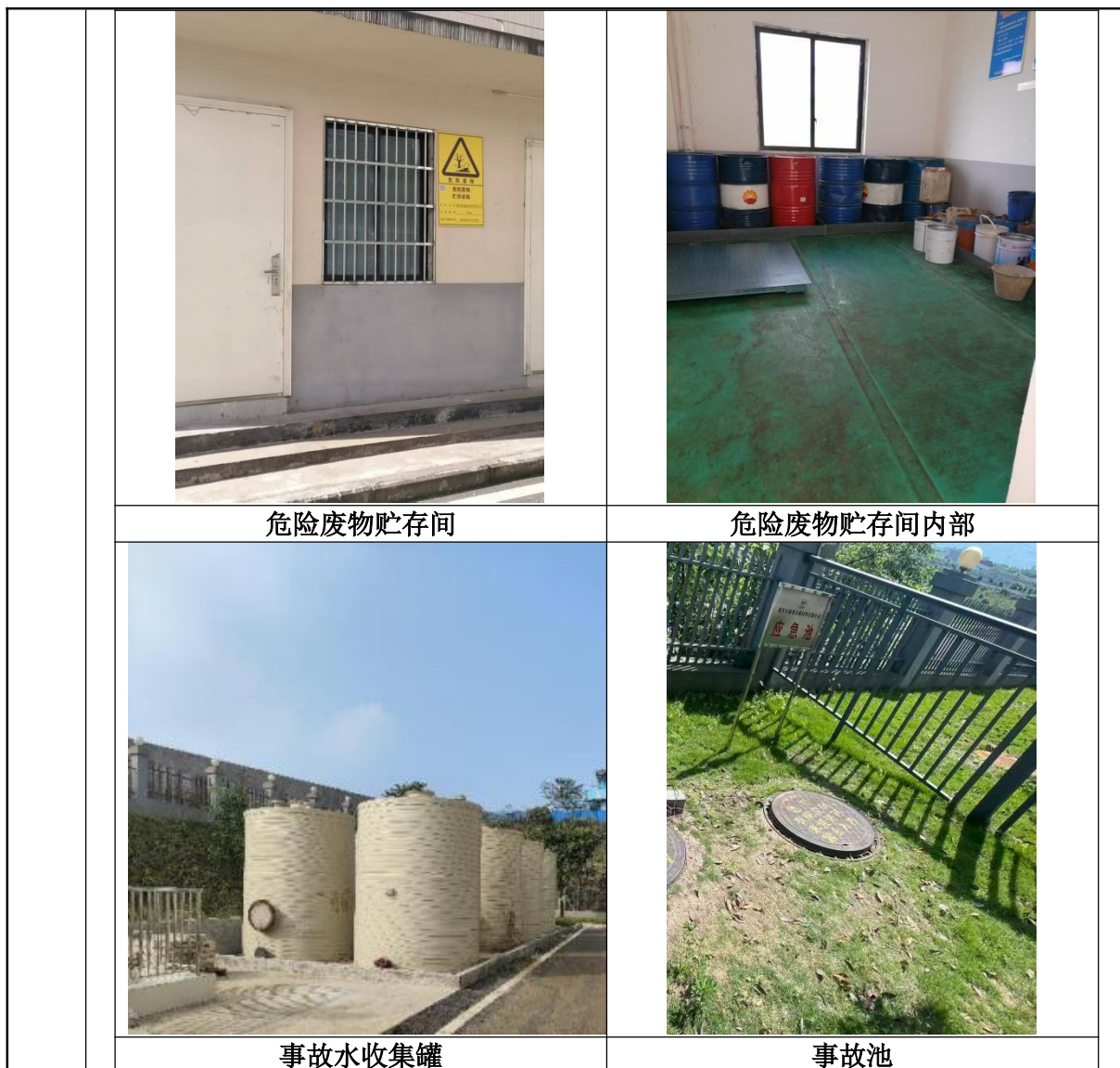
图2.11-1 本次主要依托工程现场照片
