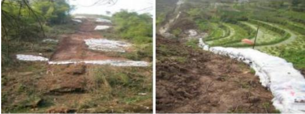
图3.1-4 施工作业带临时水工保护措施示意图
