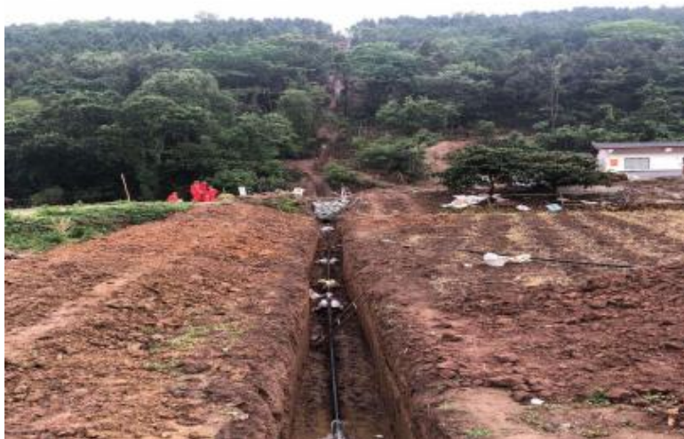
图3.1-3 同类型管沟开挖及布管实景示意图
